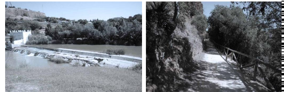
Figura 168: Tramo medio del río Guadaíra, de unos 10 kilómetros de longitud, que discurre entre el Molino Hundido y el Molino de Pelay-Correa, junto con el parque urbano de Oromana. 42
